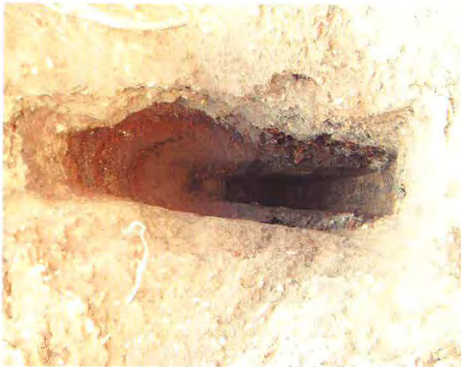
PU1 - Sondage à la pelle mécanique
