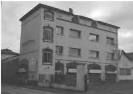
Bâtiment Jules Weitz
